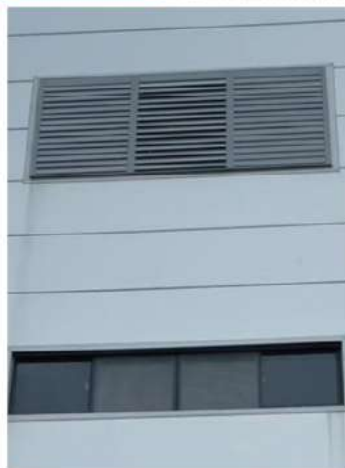
電動百葉窗裝上 風扇後示意圖
